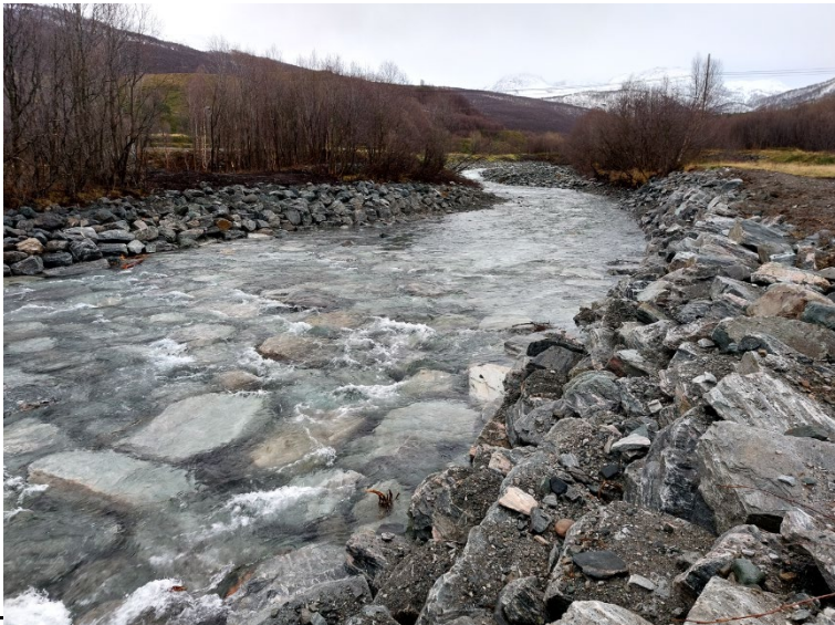
Utført erosjonssikring oppstrøms gamle Badderen bru Foto: NUT
