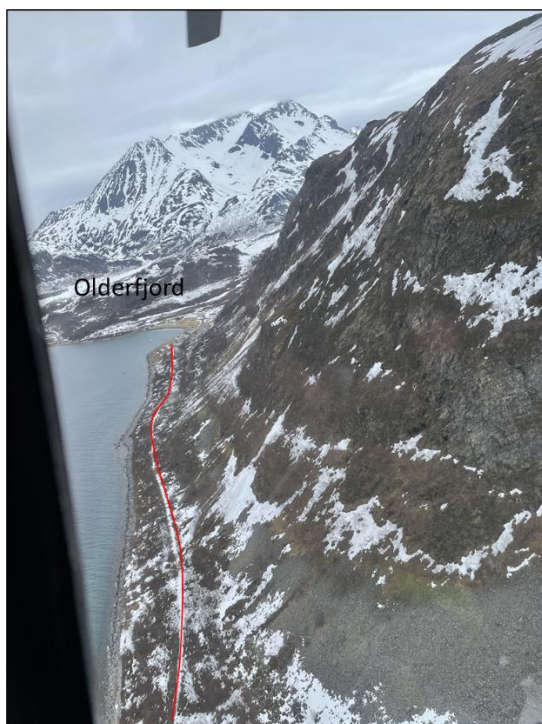
Figur 16: Oversiktsbilde over strekningen fra Reinfjorddalen til Olderfjorden. Bilde tatt mot nordøst.
