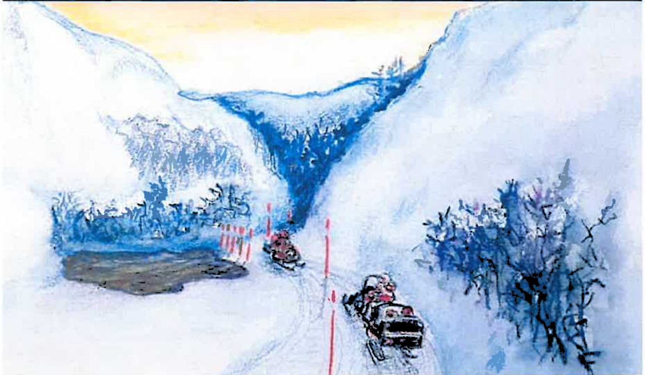
5: Fastmerking. Siden fastmerker ikke vibrerer i vinden fester snøen seg bedre på disse enn på andre stikker
