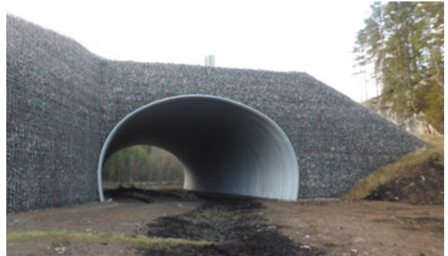
Eksempel på undergang for vilt utført som gabionmur under vei 27 ved Borås i Sverige. Foto: Henrik Undeland.
