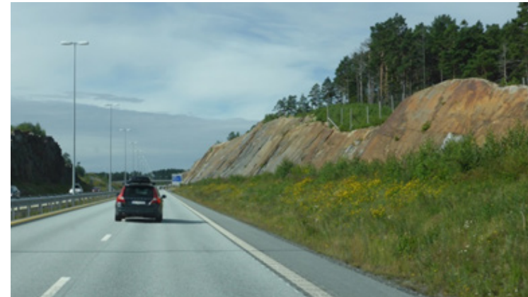
Fjellveggene langs en vei er viktig del av sideterrenget. Skråninger legges med helning for å minimere rekkverksbehov. Fjellskjæringer skal tilpasses bergets kvalitet. Fjelllets helning vil variere etter de gitte forhold. Bildet er tatt på E18 mellom Grimstad og Kristiansand. Foto: Henrik Undeland.
