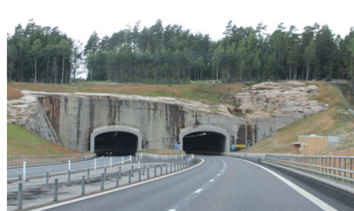
Bildet over viser eksempel på et teknisk bygg langs E6 ved Tanum. Bygget er kledd med tre (eik) som gjør at bygget glir godt inn i veiens sideterreng i tillegg til at det er plassert i en nisje og synes derfor nesten ikke, men opprettholder likevel etterspurt funksjonalitet. Foto: Katharina Nyström
