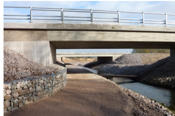
Bildet over er fra vei 50 i Skänninge i Sverige. Utformingen skaper et lyst rom for de som passerer under veien. I tillegg gis de en god visuell kontakt med elven. Foto: Henrik Undeland.
