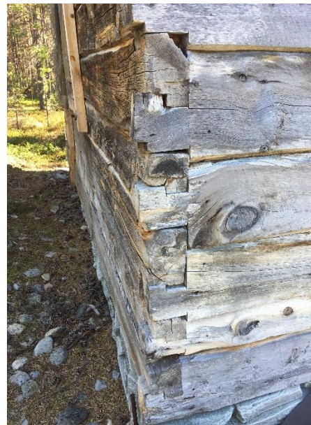
Kamlafting er kjent fra hele landet i tillegg til svensk og finsk side av Tornedalen. Den ble først tatt i bruk på 1700-tallet og var da særlig brukt i kirkebygg før den på 1800-tallet ble tatt i bruk i våningshus. Foto: L. Brekmoe
