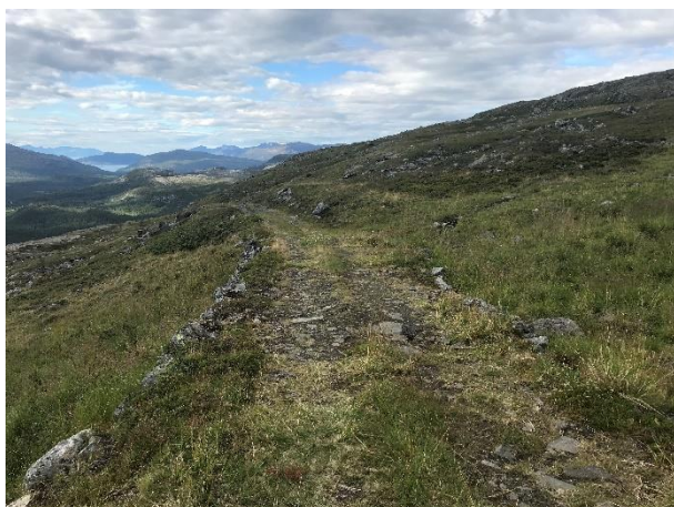
Utsyn ned mot Storskjæringa på vei opp mot Middavarre. Veianlegget går helt ned til Kvænangselva og er svært godt bevart. Foto: L. Brekmoe.
