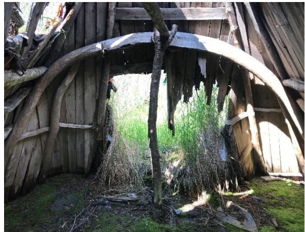
Gammene er spesielle fordi de bruker den gamle bealjekonstruksjonen i kombinasjon med nyere byggematerialer. Gammen måler 5,5 x 5m. Foto: Sametinget.
