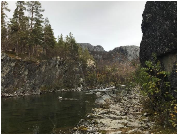
Oppmurt vei på sørsiden av Kvænangselva. Foto: L. Brekmoe
