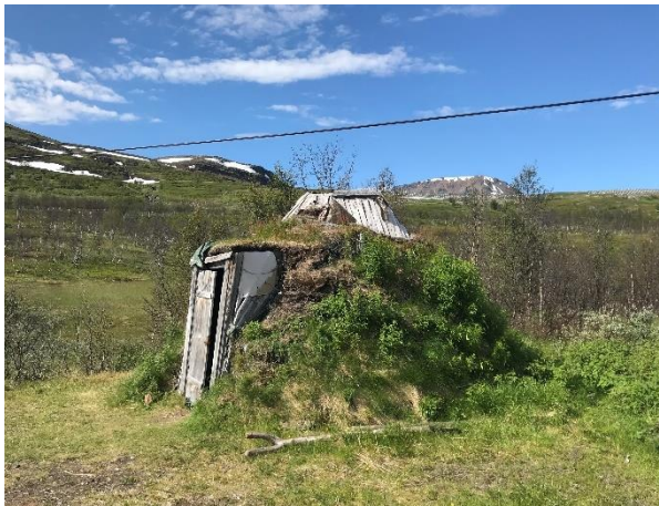
Gammene er spesielle fordi de bruker den gamle bealjekonstruksjonen i kombinasjon med nyere byggematerialer. Gammen måler 5,5 x 5m. Foto: Sametinget.
