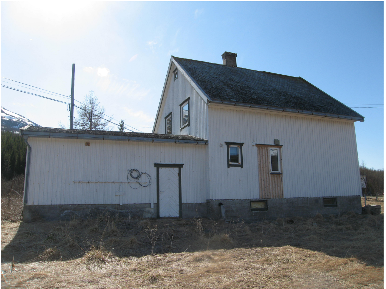
Fasade mot sjø og uthus.
