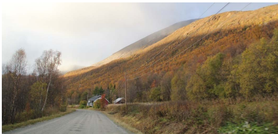
Figur 10) Fv. 360 gjennom bygda Nyvoll. Fjellsiden bak er skredutsatt område fra Pålfjellet. Foto: O.A. Helgaas
