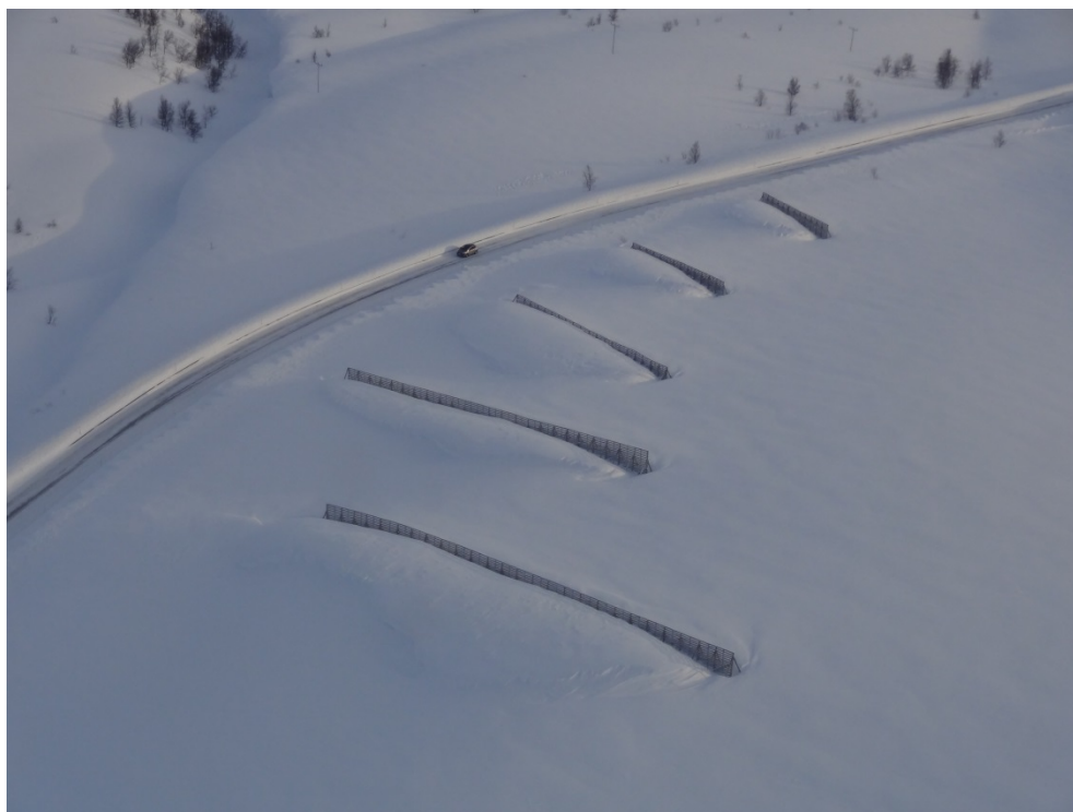
E6 Kvæangsfjellet – eksisterende snøskjermer
