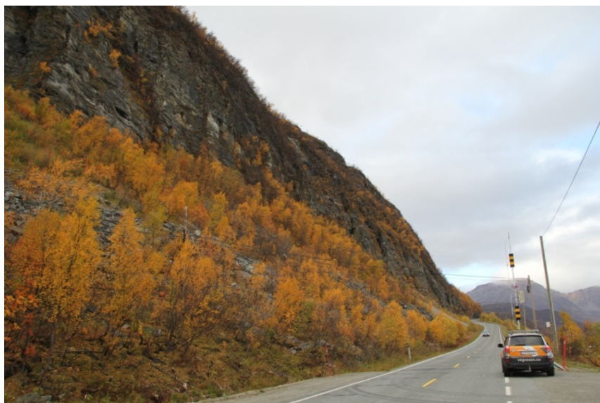
Figur 14) Foto fra Rakkenesura ved østre bom Kvænangsfjellet
