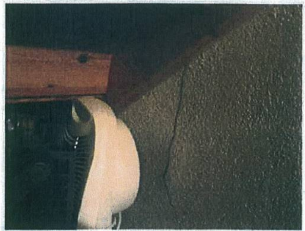
Bilde 18: Spekker i støtteveggen under trappa.
