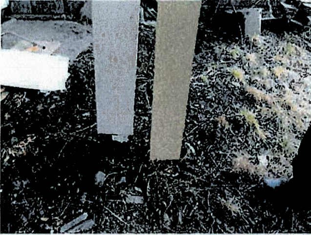
Bilde 9: Støtte/innervegger forskjøvet i lengderetningen. Ingen av dørene kan lukkes igjen
