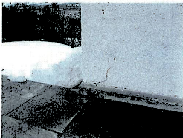
Bilde 5: Store setningssprekker i mure, forsøkt avlastet med ny støttemur utenpå.
