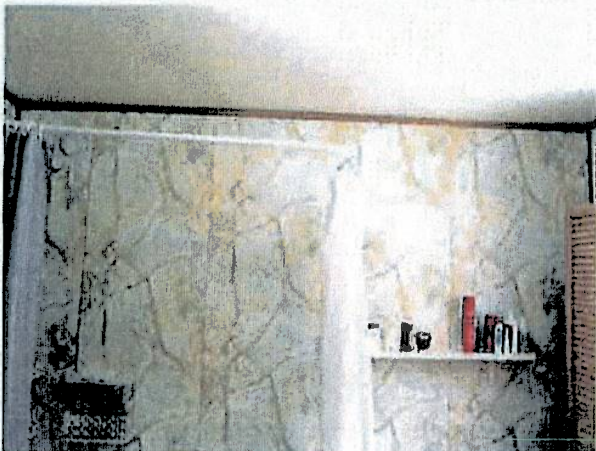
Bilde 11: Baderoms plater på bad/vaskerom, forskjøvet
