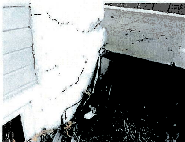
Bilde 6: Grunnmuren rundt samme hjørne, vinduene i underetasjen kan ikke åpnes pga skjevhetene
