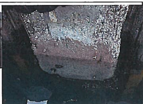
Bilde 6 Nærbilde av ett av stedene med manglende fendring.
