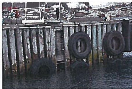
Bilde 7 Manglende fender på østsiden av kaia.
