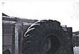
Bilde 6 Nærbilde av ett av stedene med manglende fendring.
