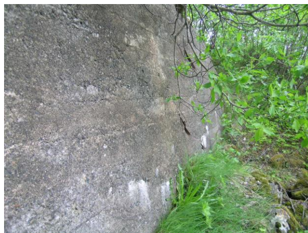
Figur 19 – Kalkutfelling, kratt og jernbånd.
