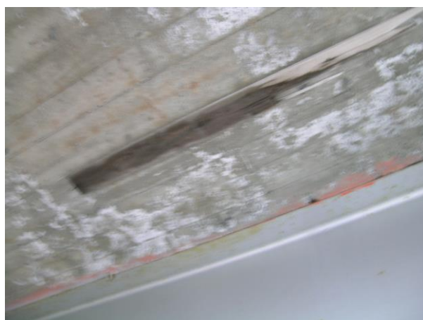
Figur 53 – Rester av forskaling.
