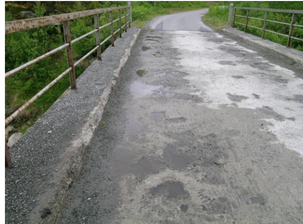
Figur 9 – Hullete veidekke.
