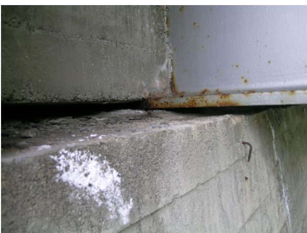
Figur 16 – Korroderte opplager.
