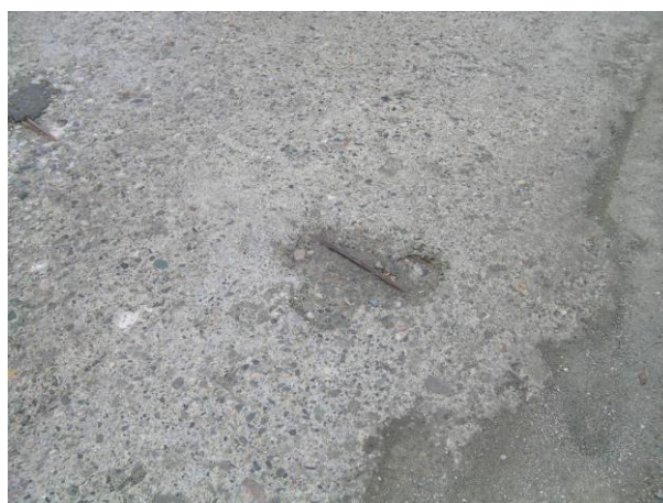
Figur 39 – Frilagt armering på bruplata.
