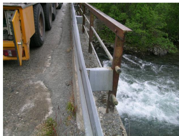
Figur 33 – Farlig rekkverkende.
