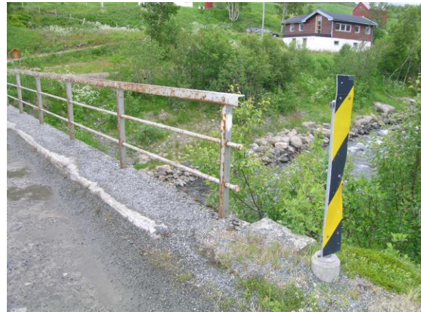
Figur 12 – Utstikkende armering på kantbjelke. Figur 13 – Farlig rekkverk og grusansamling.
