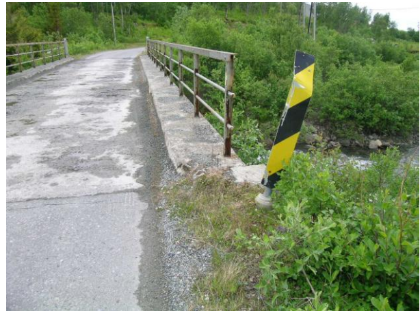
Figur 7 – Avslutning på rekkverk.
