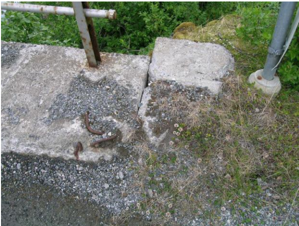
Figur 12 – Utstikkende armering på kantbjelke. Figur 13 – Farlig rekkverk og grusansamling.
