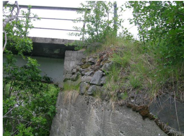
Figur 25 – Løs fylling akse 2.
