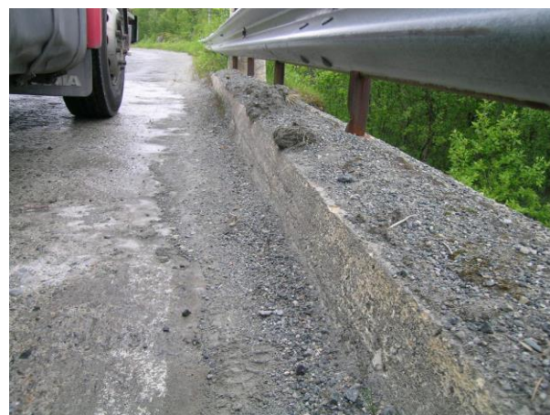
Figur 35 – Grus på kjørebane og kantbjelke.
