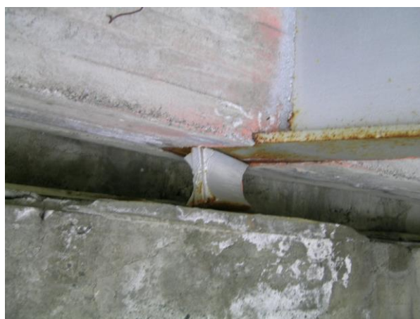
Figur 57 – Forskjøvet opplager.
