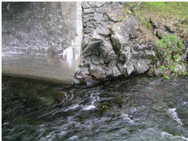
Figur 42 – Løs fylling landkar akse 2.
