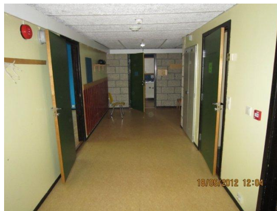
Korridor ved planlagt kontordel.
