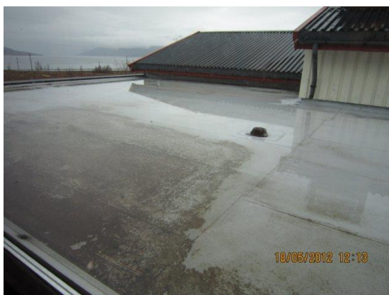
Eksisterende flatt tak fores opp.
