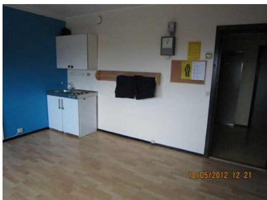
Eksisterende kontorer bygges om til nye.
